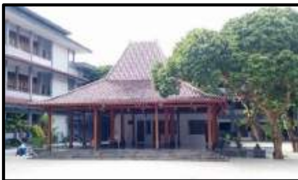
Pembangunan Joglo dan Kantin FMIPA
